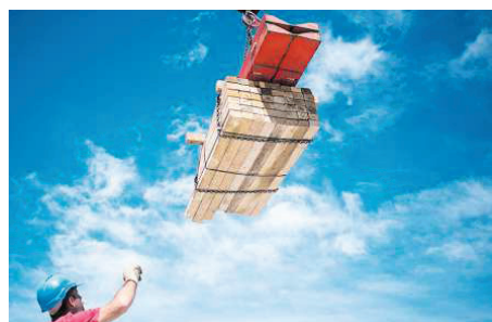
Mit dem Kran werden die Bauteile mit Material und Baustoffen versorgt. Die Verständigung mit dem Kranführer läuft über Funk.
