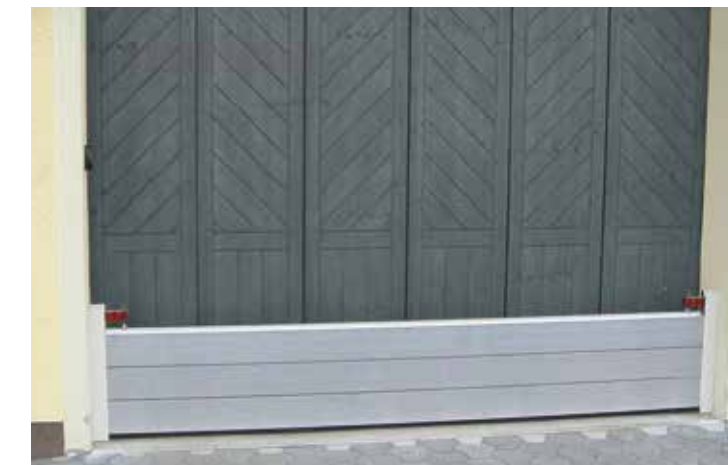
Garagentor mit montierter Schutzwand in der Leibung.
